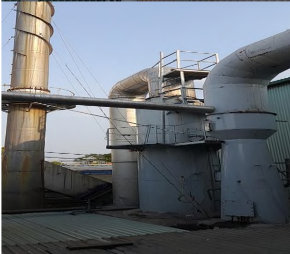
Hình 3. 7. Hình ảnh thực tế hệ thống xử lý khí thải lò hơi (sử dụng chung cho 2 lò hơi)
