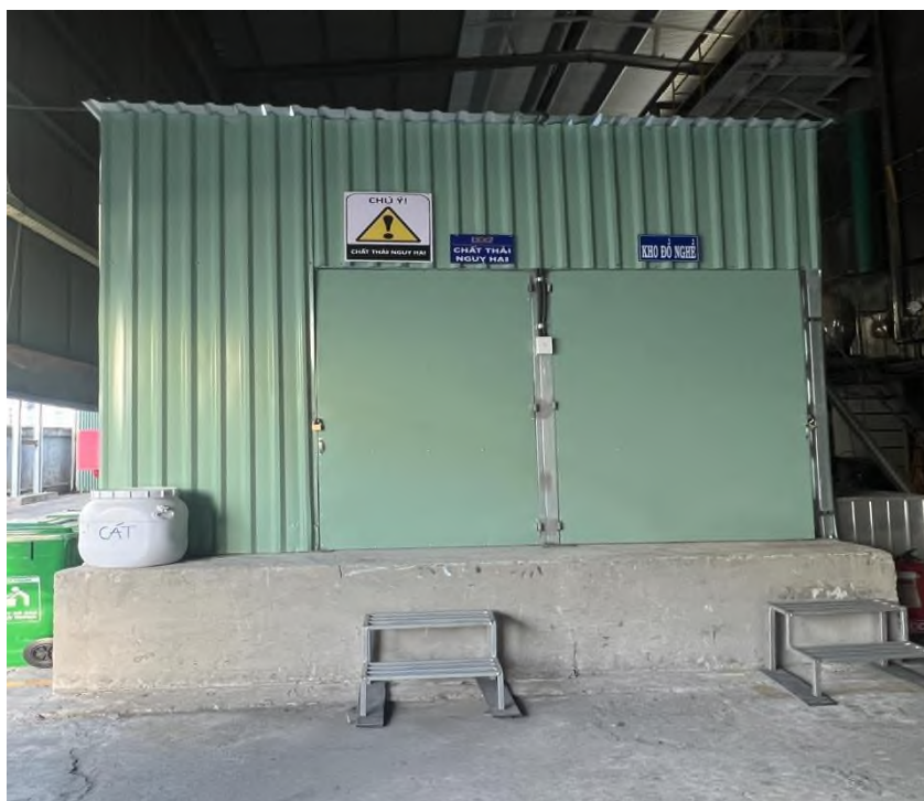
Hình 3. 12. Hình ảnh thực tế kho chứa chất thải nguy hại của nhà máy
