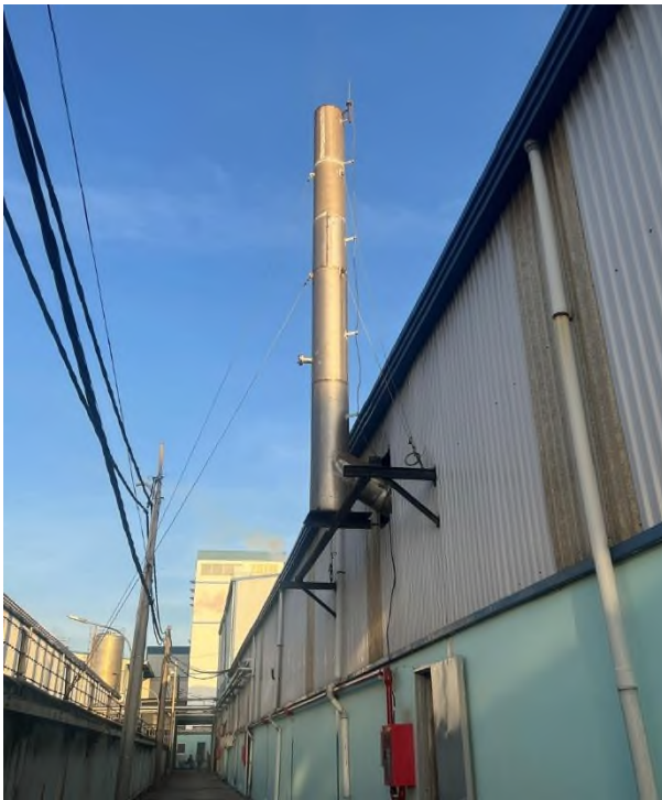
Hình 3. 9. Hình ảnh thực tế hệ thống xử lý mùi, ẩm từ máy sấy hèm
