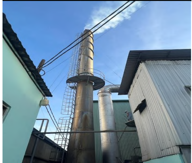
Hình 3. 7. Hình ảnh thực tế hệ thống xử lý khí thải lò hơi (sử dụng chung cho 2 lò hơi)
