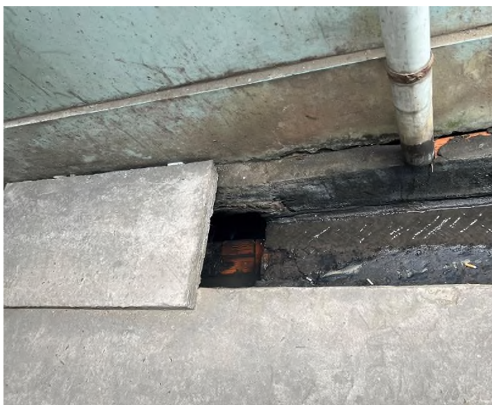
Hình 3. 2. Hình ảnh công thoát nước mưa thực tế của Dự án
