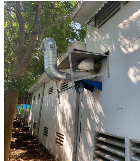
Ống thải công đoạn pha trộn hóa chất
