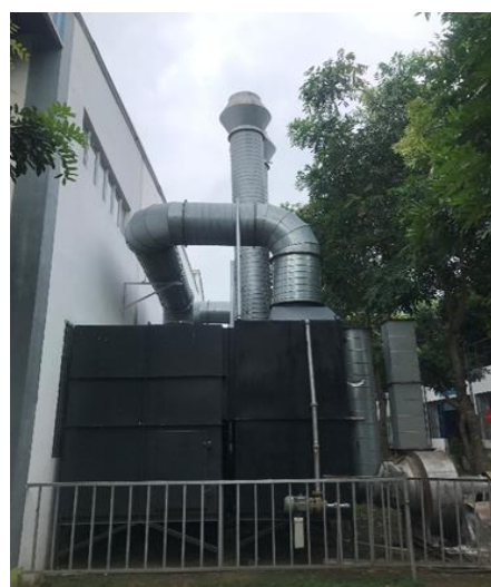
Hình 3. 11 Công trình xử lý bụi, khí thải công đoạn cắt laser
