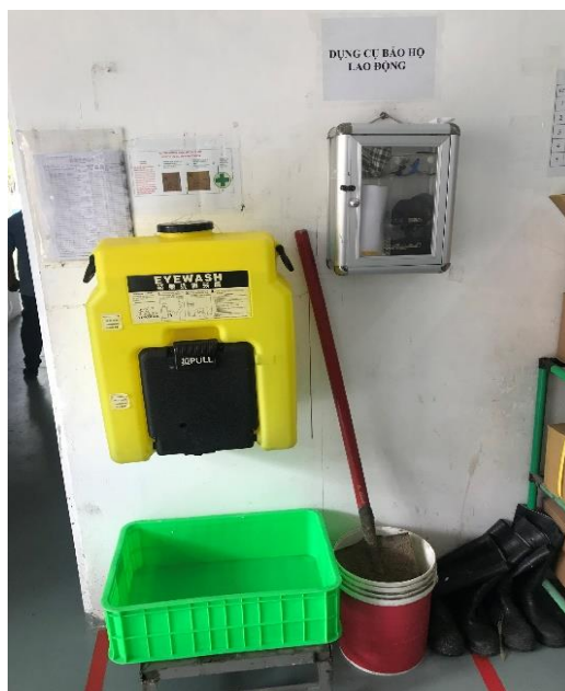
Hình 3. 24 Máy rửa mắt, vòi tắm được bố trí tại sơ sở
