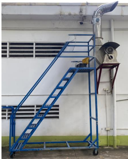
Ống thải công đoạn pha trộn hóa chất
