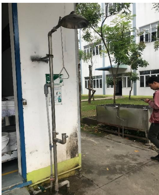
Hình 3. 24 Máy rửa mắt, vòi tắm được bố trí tại sơ sở
